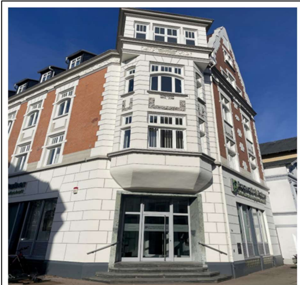
Das Gebäude Nordersteinstraße 44 (und sein Nachbar Nr. 43) gehört zu den wichtigen denkmalgeschützten Geschäfts- und Wohnhäusern in Cuxhavens Innenstadt. In der NS-Zeit war hier – in unmittelbarer Nähe zur Innenstadt – die Cuxhavener Bank ansässig, in deren Umfeld auch die Familie Gotthelf lebte und arbeitete. Das dreigeschossige giebelständige historisierende Gebäude mit ziegelgedecktem Satteldach wurde 1905 nach Plänen des Architekten Rudolph Glocke für das Hamburger Bankhaus Calmann gebaut. Zwei Schauffassaden zur Nordersteinstraße und zum Holstenplatz mit Fassaden im Wechsel von backsteinsichtigen Flächen mit Putzdekor prägen das Haus. (Quelle: Wikipedia)
